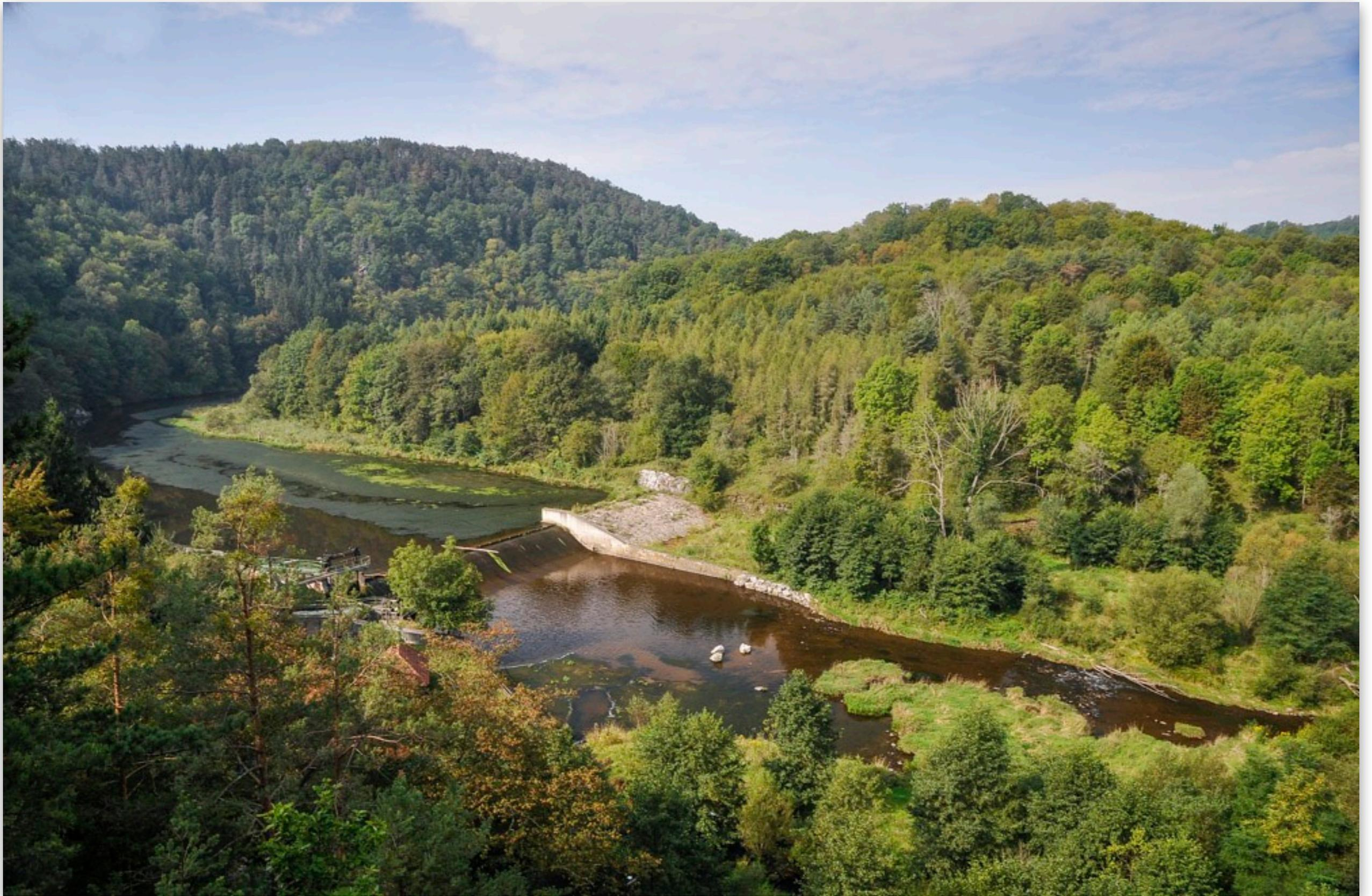
**Die Entsorgung des alten Wehrs will man sich ersparen, indem es hinter einer neuen, flussabwärts gebauten, 1,6 m höheren Staumauer geflutet wird.**
