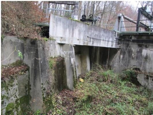
Abbildung 10 (links): Das Wasserschloss beim Krafthaus
