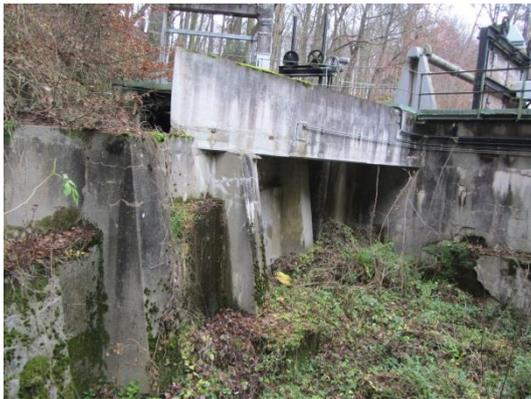
Abbildung 10 (links): Das Wasserschloss beim Krafthaus
